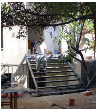
FOTOS DE LA ESCALERA DEL PATIO EN ESTADO ACTUAL Y EN OBRA.
